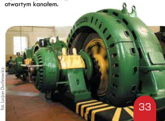
Europy. Warto zobaczyć, jak pięć turbin typu Francis i pięć generatorów pracuje od czasu ich zainstalowania w latach 1913-1924. Około 500 m przed jeziorem Głębokim wybudowano kanał kierujący wody rzeki Słupi i Bytowej do jeziora Głębokiego. Z jeziora wody wyprowadzono podziemną sztolnię, a następnie otwartym kanałem.
