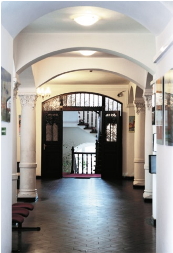
Stropy oraz podtrzymujące je kolumny na pierwszym piętrze The ceilings on the first floor and pillars propping them Decke und unterstützende Säulen im ersten Geschoss
